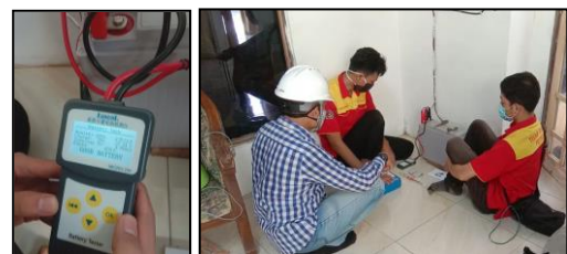
Gambar 6. Pengecekan kondisi baterai
