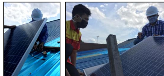
Gambar 5. Proses pemasangan modul surya
